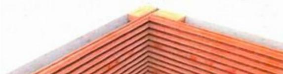
Aplica para método 1 y 2 en esquina exterior. Únicamente método 2 para esquina interior.
