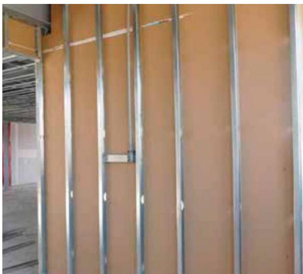
**Advertencia:** Si va a instalar la lámina vertical debe instalar la estructura en sentido horizontal y viceversa.
